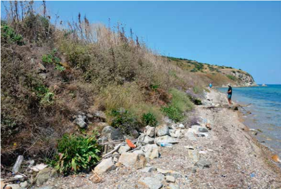
Fig.9: Kıyı Hattı Enerjisa Duvarlar.
